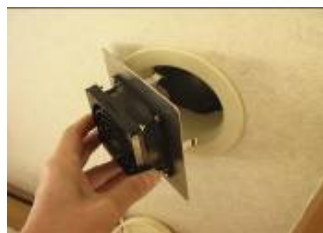
ファンをエアコンスリーブにセット (殆どの規格の口径に対応できます)
